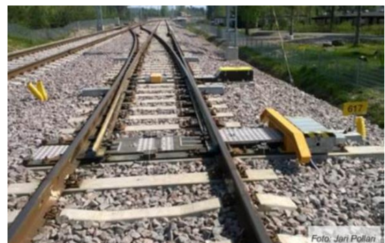
Fig.2 schimbător simplu de cale (macaz, șine de legătură, inimă simplă, șine de rulare cu contrast, dispozitiv de acționare)
