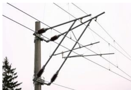
Fig.2. Suspensie catenara
